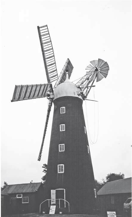
5枚翼のSibsey Trader Millのテイルファン
